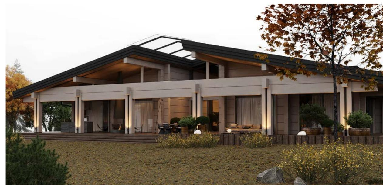
Ключевая особенность проекта заключается в использовании бруса с крупным, нестандартным сечением (600 × 400 мм), сделанного на заказ в Сибири. Такой брус смотрится основательно, так как сомасштабен размеру дома, общая площадь которого составляет 1069 м, а высота потолка достигает до 7,1 м, и отсылает нас к классическим деревянным северным домам. В двускатную кровлю традиционной формы интегрирован световой фонарь, наполняющий внутреннее пространство светом и воздухом. **Y MAG**
